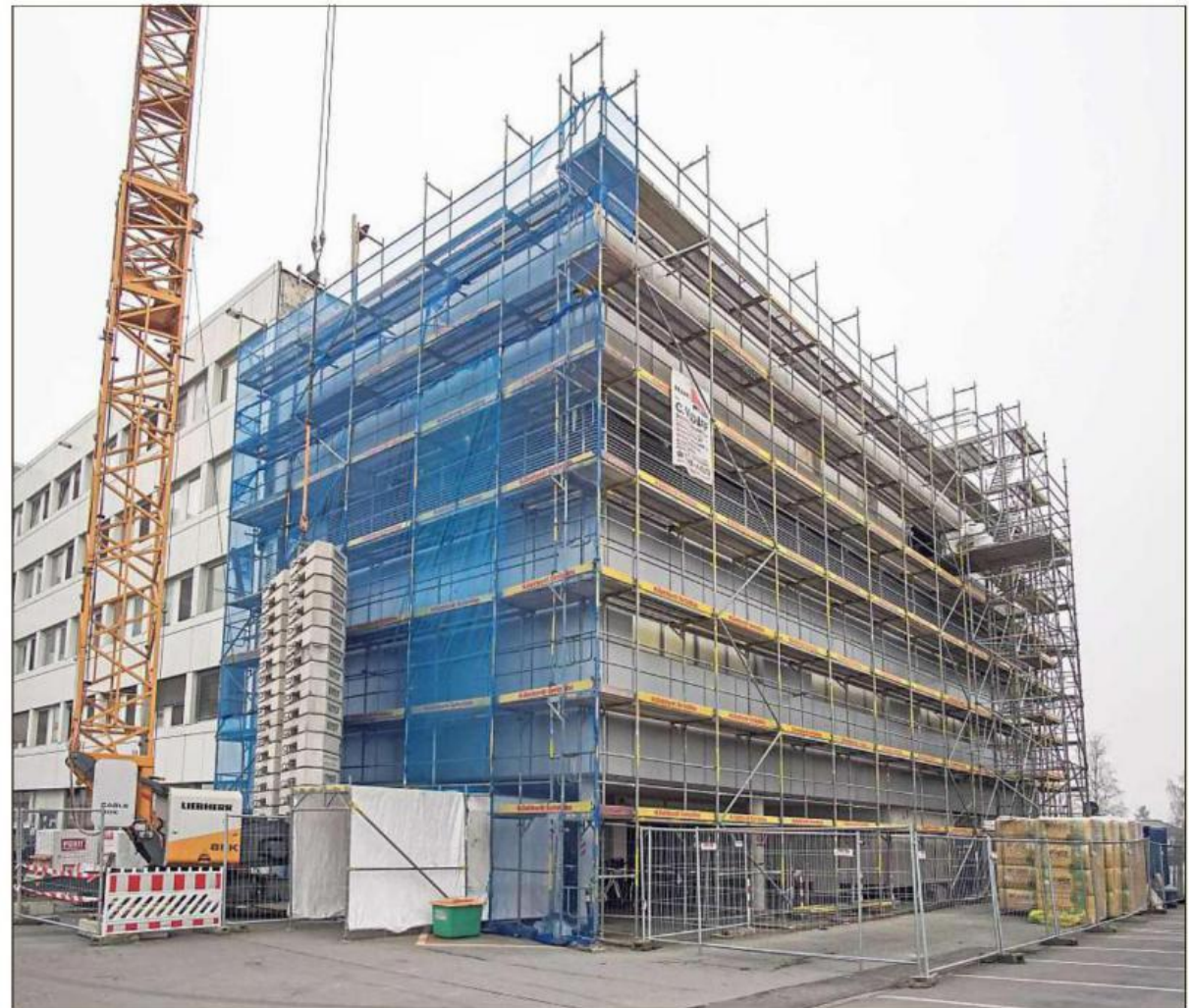
Für rund sechs Millionen Euro wird aktuell das Zentrum für Endoskopie und Kardiologie am Josephs-Hospital in Warendorf erweitert. Die Inbetriebnahme erfolgt im Herbst. Foto: Josephs-Hospital Warendorf
